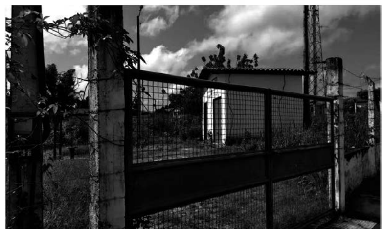
Fachada Frontal da Estação Elevatória de Murici dos Portelas.
