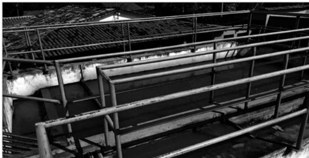
Imagem da Estação de Tratamento de Água localizado no perímetro da Agespisa (Unidade Municipal).
