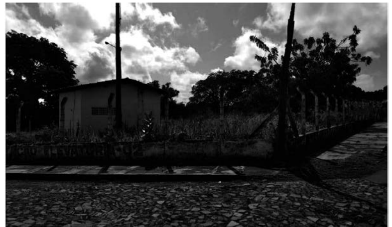
Foto da Estação Elevatória do Município de Murici dos Portelas.
