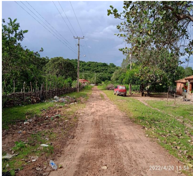
Foto 05 - Rua projetada 02 - localidade Serragem
