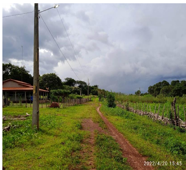
Foto 04 - Rua projetada 01 - localidade Serragem
