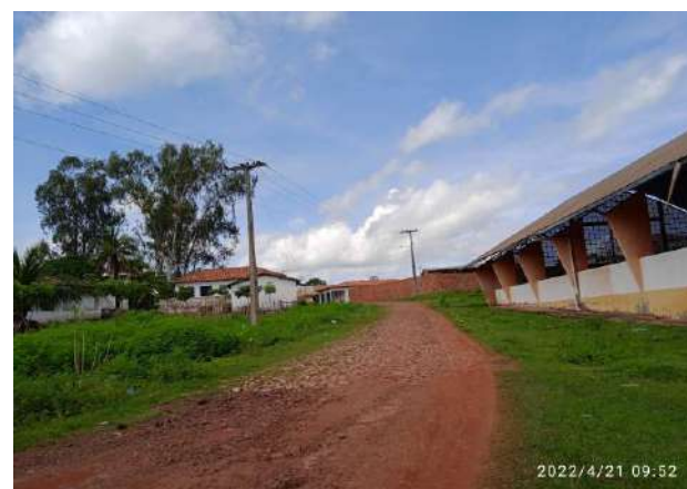
FOTO Nº 04 - TRECHO 02: SEDE ATÉ LOC. CAIÇARA
