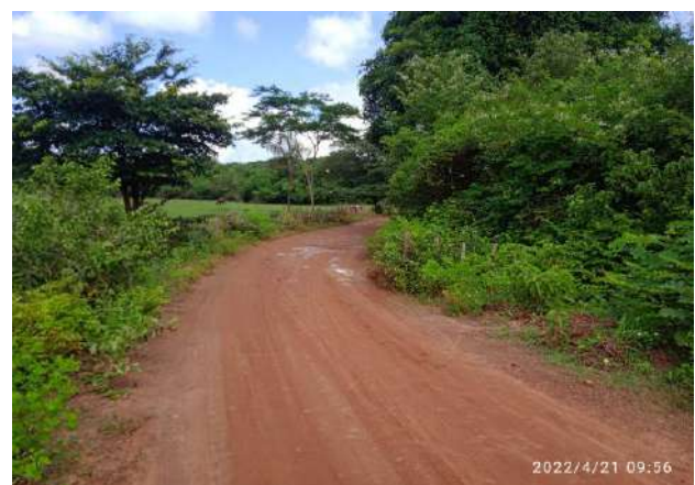
FOTO Nº 05 - TRECHO 02: SEDE ATÉ LOC. CAIÇARA
