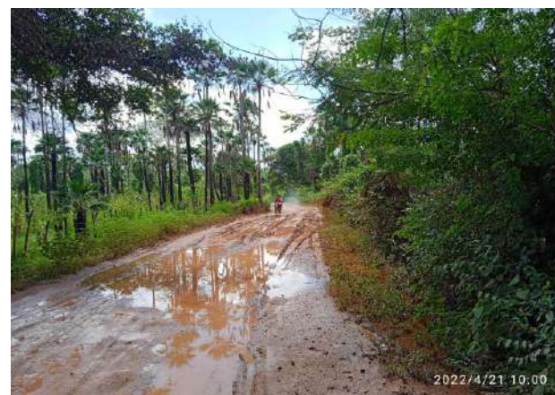
FOTO Nº 06 - TRECHO 02: SEDE ATÉ LOC. CAIÇARA
